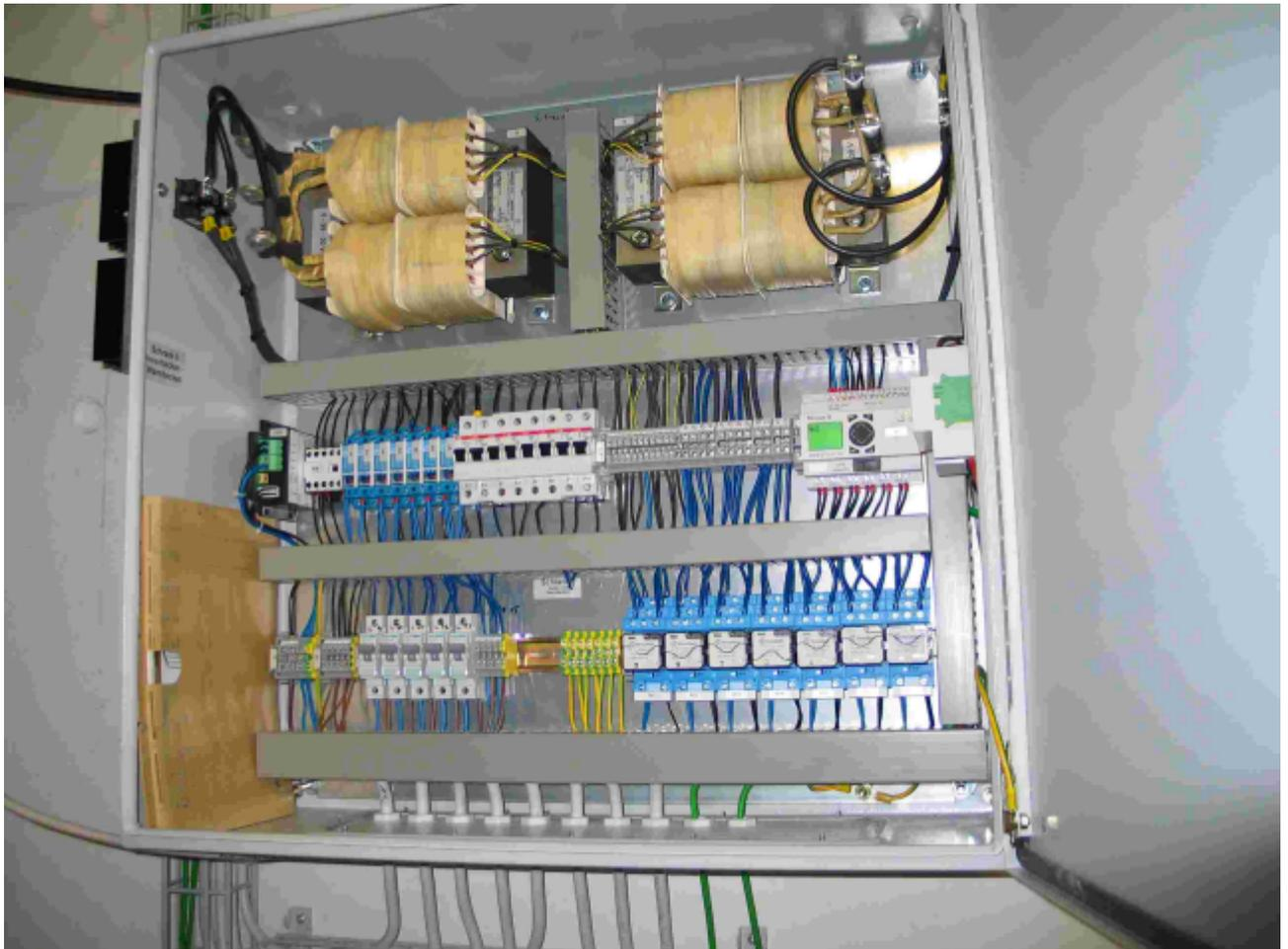
Gleich Funktion wie Schaltschrank 1. Deshalb Siehe die Beschreibung oben von Schaltschrank 1. Außerdem kann die Innenbeckenbeleuchtung unabhängig von der Warmbeckenbeleuchtung aus und eingeschaltet werden. (Kanal 4 der EIB Fernsteuerung.)
